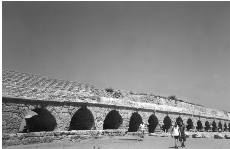
Кесария. Акведук (верхний водовод)
