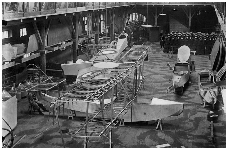
Рис. 11. Изготовление летающих лодок М-5
