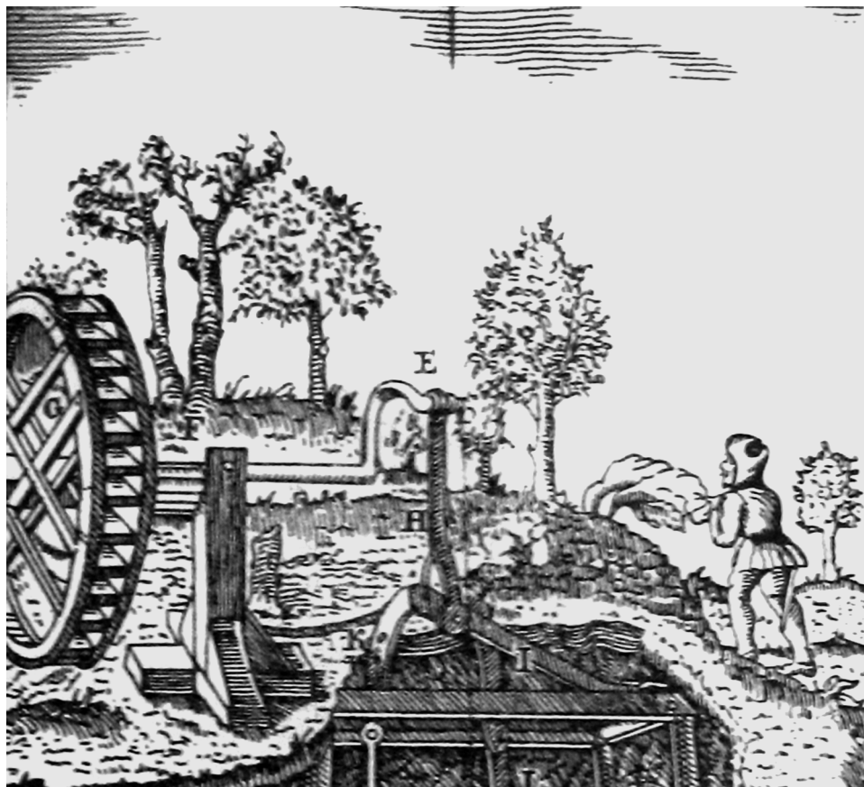
Рудокон около шахты. Фрагмент рисунка (фигура 13) из книги М. В. Ломоносова «Первые основания металлургии или рудных дел» (1763), изображающего устройство разновидности насосов, «которыми из рудников воду выливают»
