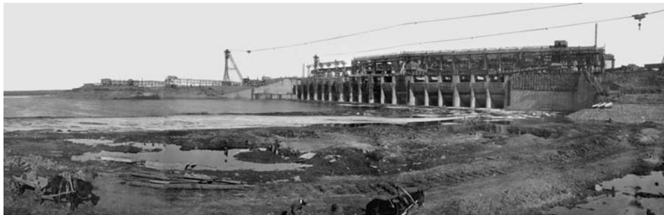
Общий вид на новое русло Шексны и строящиеся блоки Рыбинской ГЭС, 1940 г.
