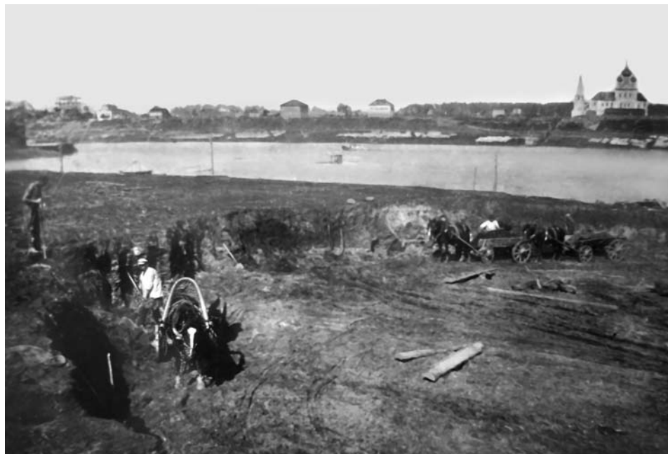
Разработка отводного канала грабарками (телегами с откидными боками) на строительстве Угличского гидроузла, 1937 г.
