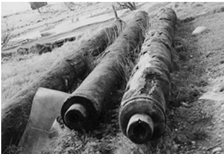
Рис. 17. Звенья деревянного соловецкого водопровода, найденные в 1988 г. при прокладке теплотрассы по ул. Северной у Филипповской часовни
