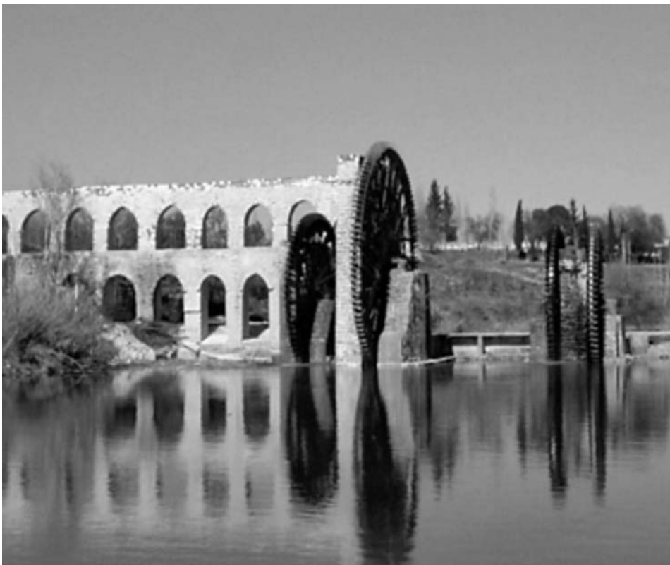
Рис. 8. Норжи – водяные колеса диаметром до 22 м. Хама. Сирия.
