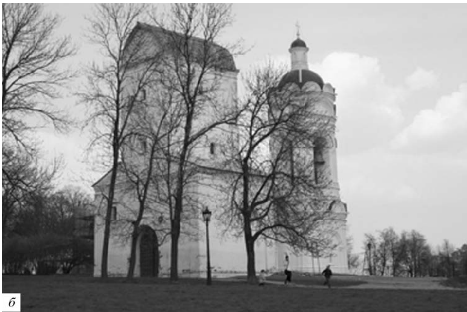
Рис. 20. а – Водовзводная башня в Музее-заповеднике «Коломенское». Москва. б – Экспозиция «Государево водовзводное дело», посвященная истории использования воды и различных водоподъемных механизмов в повседневной жизни Государева двора XVI–XIX вв. Открыта 18 декабря 2008 г.
