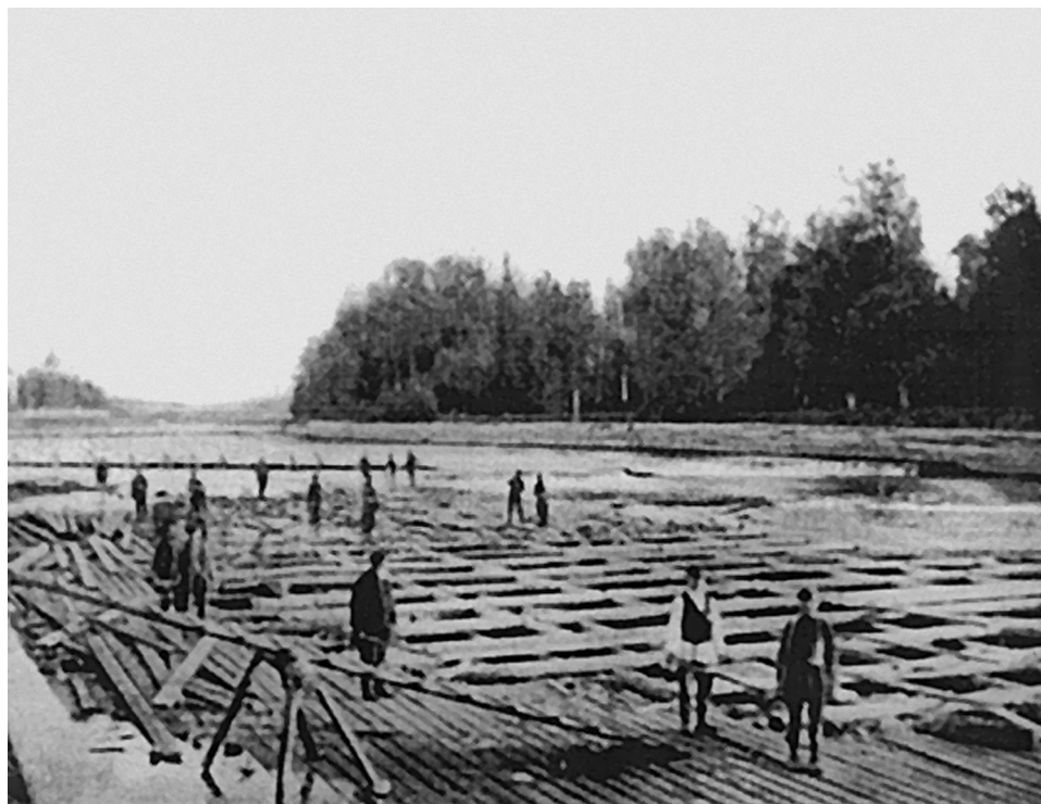
Устройство деревянного ростверка (1901)
