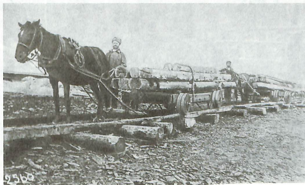
Август 1932 г. Лежневая дорога с вагонеткой; рацпредложение Совковича и Педана
