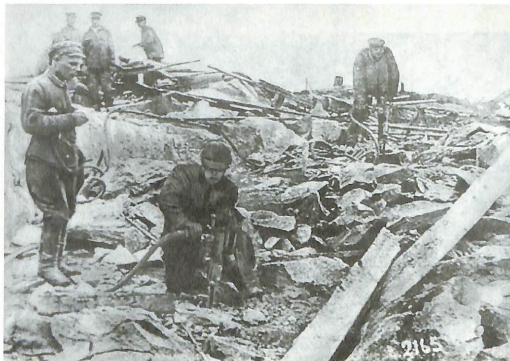
Июль 1932 г. Перфораторное бурение в скальных разработках
