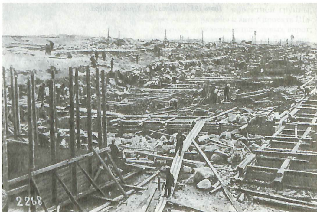
Август 1932 г. Вид на котлован верхней камеры
