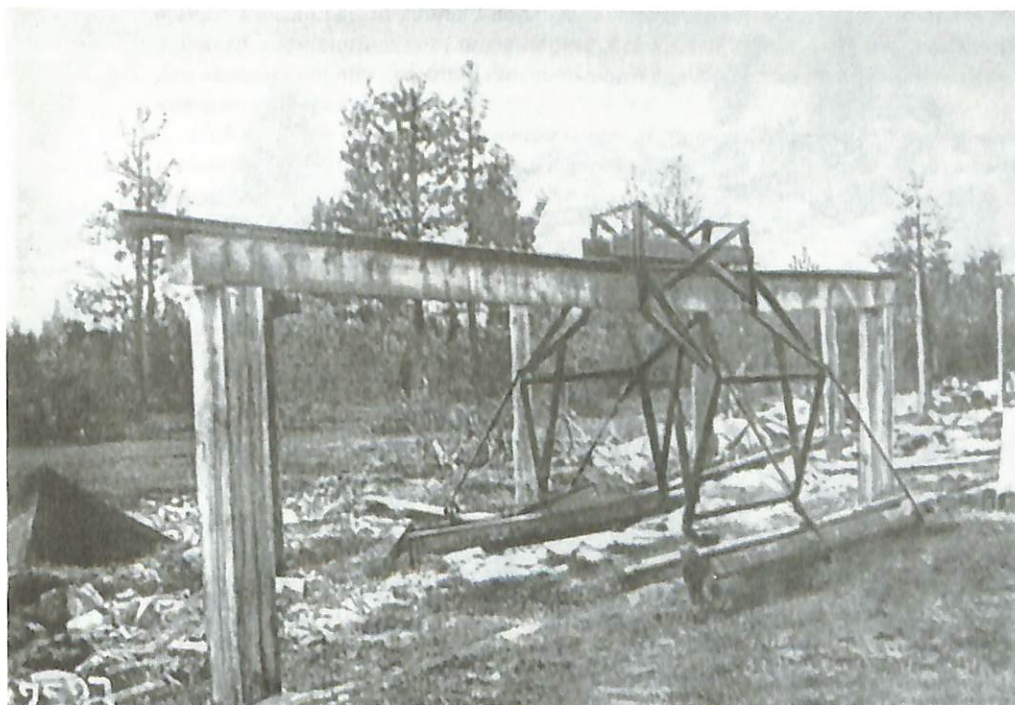
Август 1932 г. Монорельсовая дорога для перевозки бревен; рацпредложение инженера Н. П. Власова
