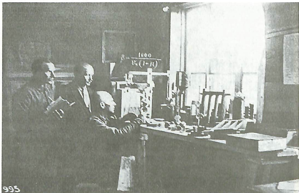
Июль 1932 г. Шлюз № 3. Определение сопротивления цемента на разрыв по Михаэлису
