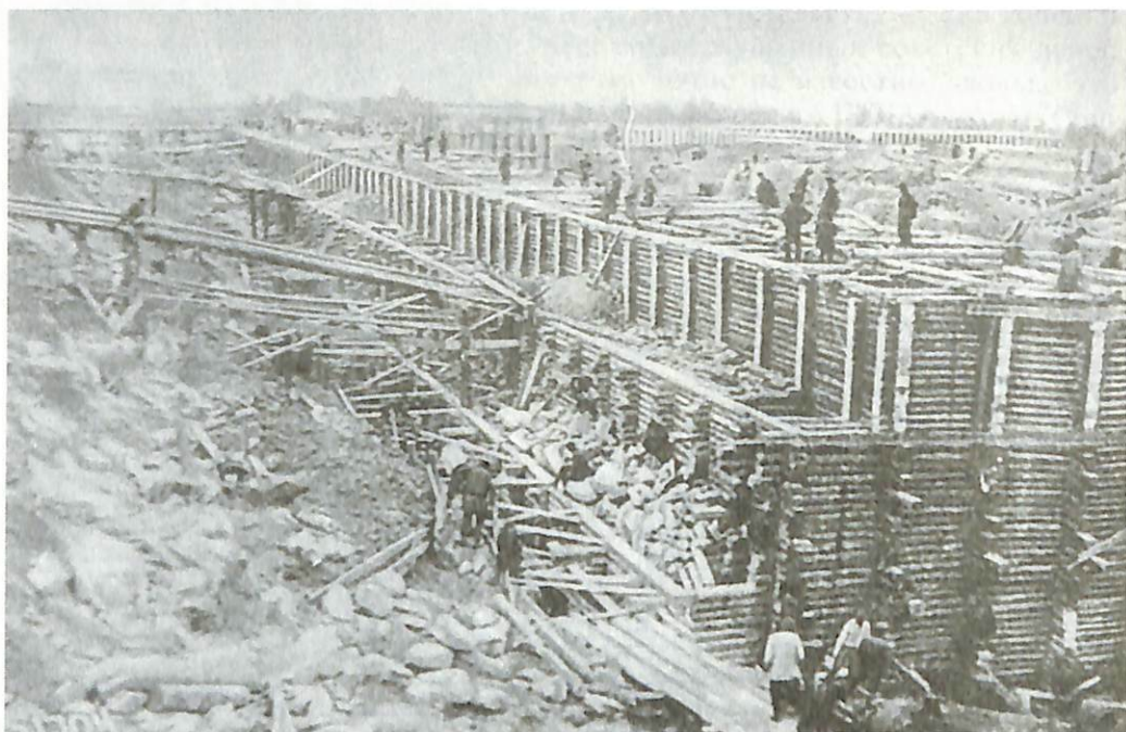
Вид на рязь восточной секции нижней камеры и траншея для дренажного коллектора. На заднем плане западный пилон нижней головы и рязь на стапеле
