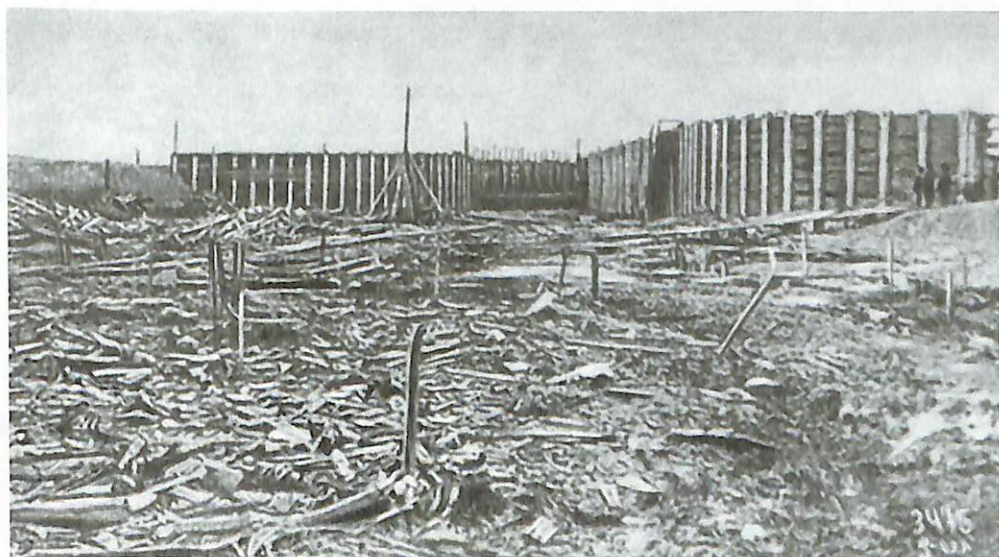
Октябрь 1932 г. Шлюз № 3. Вход в шлюз со стороны канала № 154
