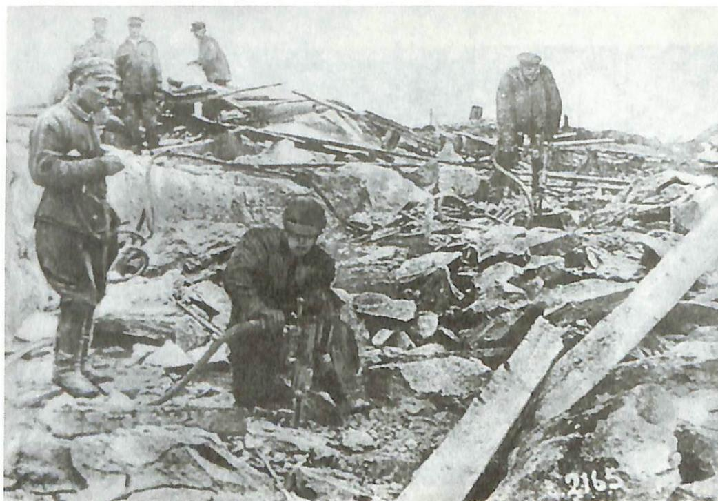
Июль 1932 г. Перфораторное бурение в скальных разработках
