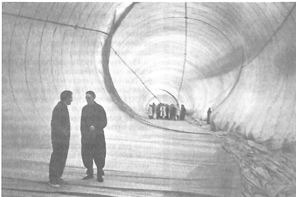
*Внутри оболочки «СССР-3» во время ее испытания на герметичность, 1935 г.*
