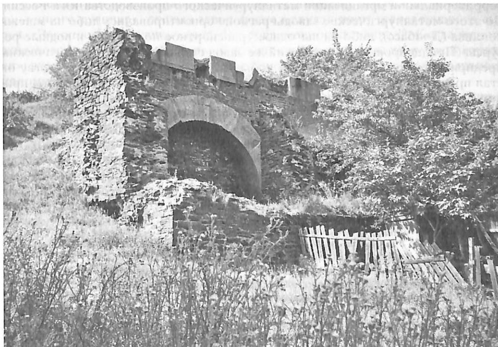
Рис. 2. Остатки моста через р. Ингулец. Мост имел один большой пролет – 95 м и четыре малых по 53 м каждый, высота 49 м. Кривой Рог. Автор – Н. А. Белелюбский, 1884 г.
