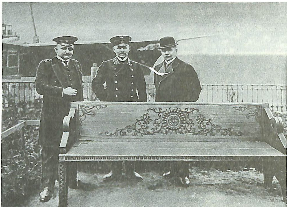
Строители храма Спаса на водах (справа-налево: архитектор М. М. Перетяткович, инженер-строитель С. Н. Смирнов, их помощник студент Института гражданских инженеров А. Г. Джорогов)
